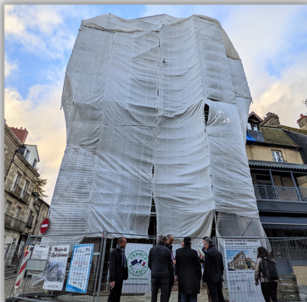
Réhabilitation de l'immeuble des sept colonnes à Alençon
